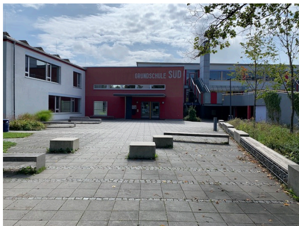
Haupteingang: Eingang für 1bGZT, 1/2eGZT, 1/2fGZT, 2bGZT
